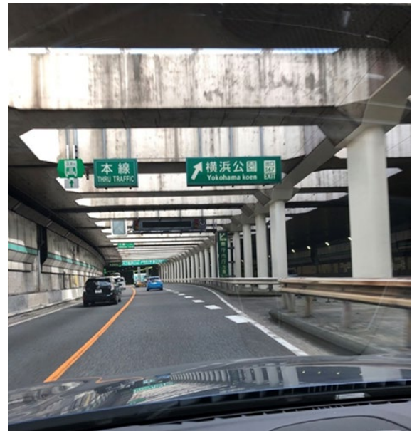
図-18 完成した地下化された高速道路（堀割形式の部、筆者 2018年撮影）
