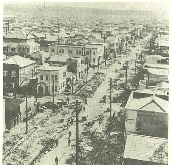
震災復興(本町通り) (昭和3年) Rehabilitation-under construction (1928)
