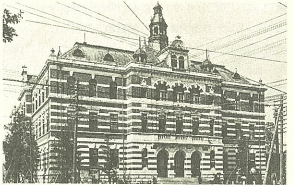
横浜市役所(明治44年) The Yokohama City Hall (1911)
