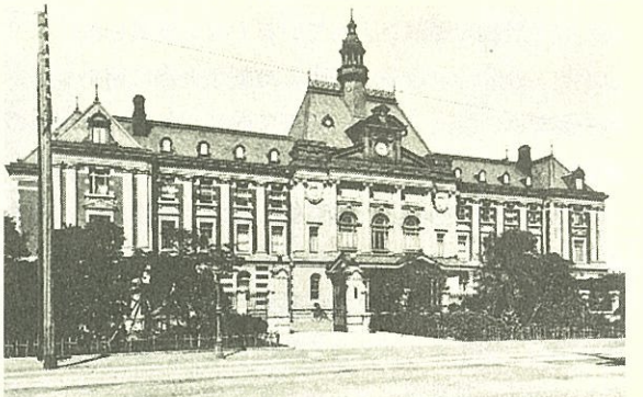
神奈川県庁(大正2年) The Kanagawa Prefectural Office (1913)
