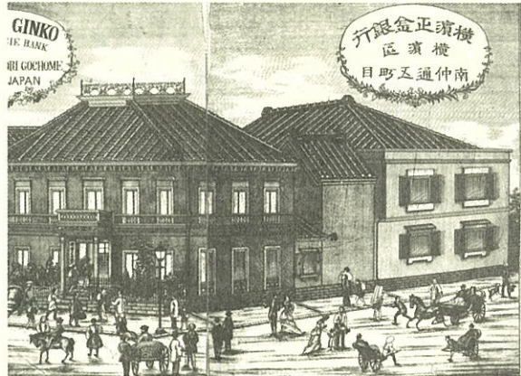
横浜正金銀行(明治13年) The Yokohama Shokin Bank (1880)
