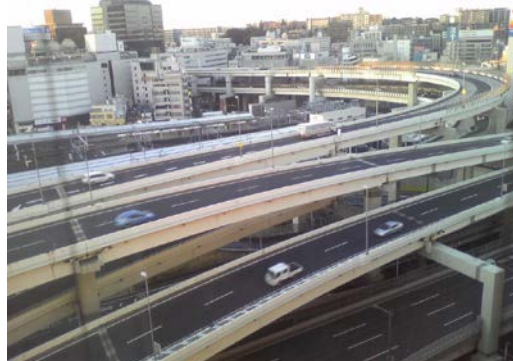
▲図 22 横浜駅東口の高架高速道路（横浜そごう百貨店より臨む）関内駅周辺もこのようになっていたかもしれない…（筆者撮影）Figure22: Scene of entangled elevated motorway routes near Yokohama railway station
